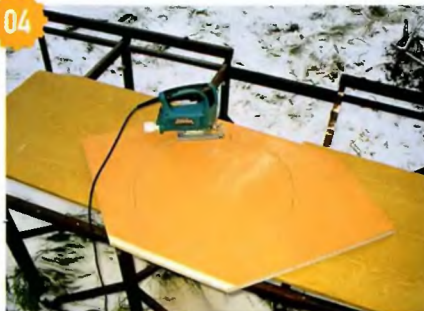
Для выпиливания отверстия под раковину хорошо подошёл лобзик.
