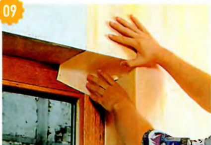
09 ...и заменяют его вставкой. Вставку выкраивают из обоев так, чтобы она соответствовала по рисунку соседнему участку обоев и проходила по перемычке до окна.
