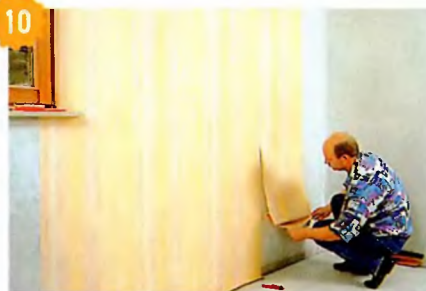
10 Так, полотнища за полотнищем завершают оклейку обоями первой стены.
