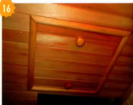
16 По периметру технического люка в потолке парилки сделали обрамление из наличников.
