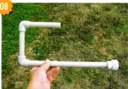
08 Насадку для налива воды в бочку сделал в виде крюка, чтобы можно было цеплять за край.
