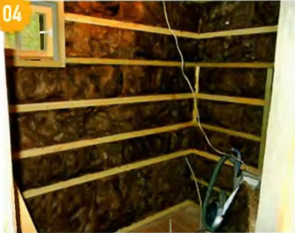
04 Утеплитель на стенах укладывали враспор между брусками каркаса.
