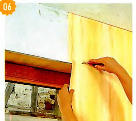
Выступающий в зону оконного проёма край полотнища подрезают сверху по оконной перемычке (выше неё примерно на 1 см), а снизу — по подоконнику.
