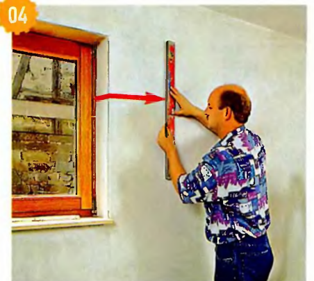
Отмерив от окна через откос ширину обоев, делают отметку и от неё проводят вертикальную линию по всей высоте стены.
