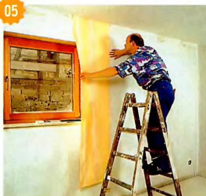
Первое полотнище приклеивают к стене слева от вертикальной линии разметки.
