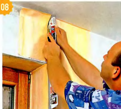
08 Оставшуюся над окном часть этого полотнища обрезают по линии, совпадающей с краем откоса...
