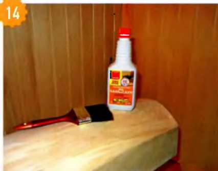
14 ...после чего обработали антисептиком Neomid для бань и саун.
