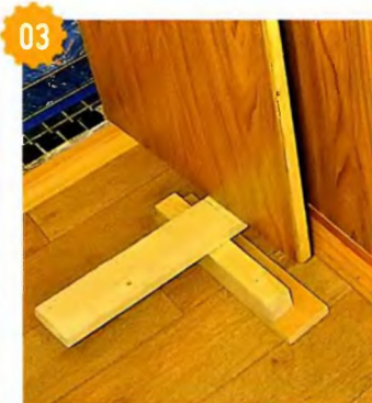
03 Снять дверь поможет простой рычаг из подручных материалов.
