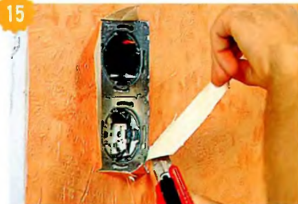
15 От концов прорези обои прорезают в направлении наружных углов блока розеток. Образовавшиеся лишние лоскуты обоев обрезают. После этого остаётся разгладить обои вокруг розеток.
