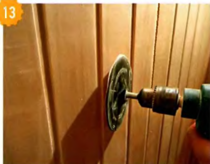
13 Поверхность вагонки после монтажа тщательно отшлифовали...
