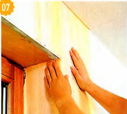
07 Левый край полотнища отгибают и наклеивают на откос.
