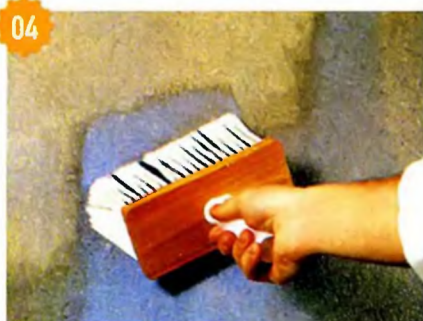
Грунтовка укрепляет основу и одновременно снижает её гигроскопичность.
