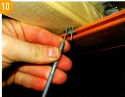
10 Монтировали вагонку на кляммеры.
