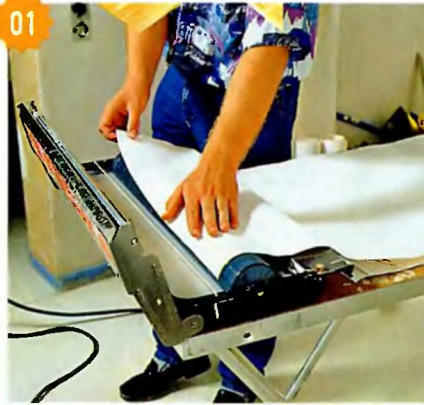
В домашних условиях клей на полотнище обычно наносят валиком или широкой кистью. Использование устройства для нанесения клея ускорит эту работу и поможет выполнить её более качественно.
