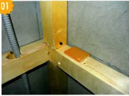
01 Деревянный каркас для укладки утеплителя и монтажа вагонки устанавливали на небольшом расстоянии от стен.
