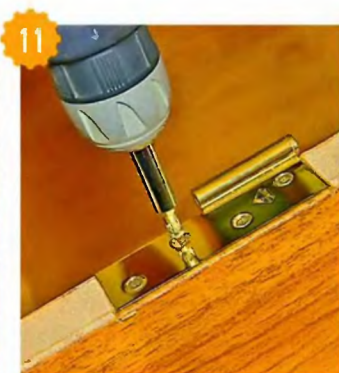
11 К полотну двери прикручивают верхнюю карту петли.
