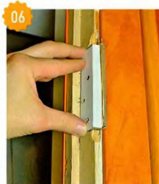
06 Если гнездо выбрано слишком глубоким, можно установить в него вкладыш из оргалита.
