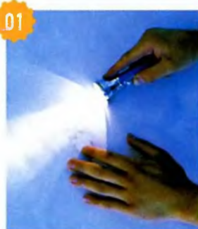
Луч света поможет найти на поверхности малозаметные неровности.
