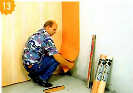
13 Одну из стен в данном случае оклеивают обоями другого цвета. Первое полотнище примыкает в углу к обоям смежной стены. Целесообразно уложить это полотнище по заранее нанесённой вертикальной линии.
