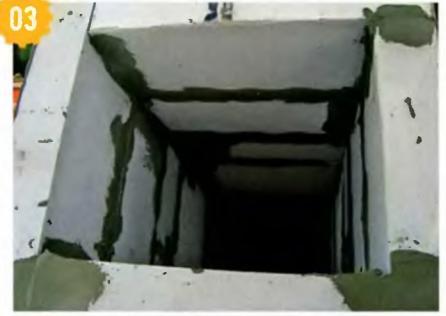
03 Ограждающий короб из газобетона для стальной трубы банной печи.
