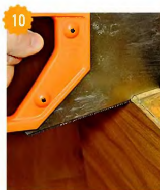
10 При необходимости гнёзда на кромке дверного полотна тоже нужно поправить.
