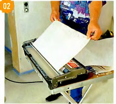
При протаскивании полотнища по валикам устройства клей равномерно распределяется по тыльной поверхности обоев.
