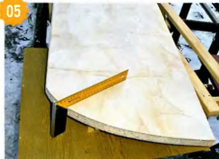
Закруглённая часть столешницы отпилена лобзиком, после чего доведена до нужной кондиции ленточной шлифмашинкой.
