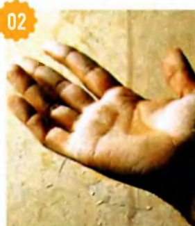
Если на руке, которой провели по стене, остаются следы, последнюю следует зашпаклевать.
