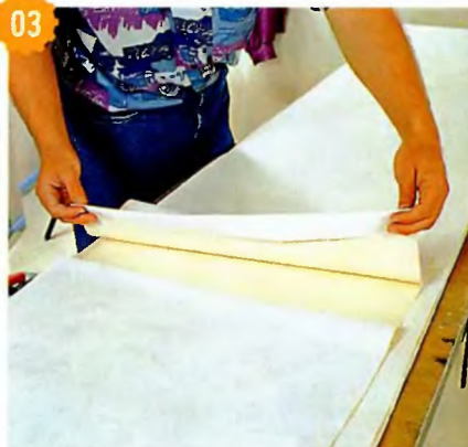
Полотнище складывают, совместив заподлицо его боковые кромки. Выдерживают промазанные клеем полотнища в сложенном виде.
