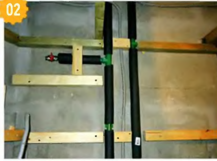
02 Внутри каркаса проложили коммуникации.
