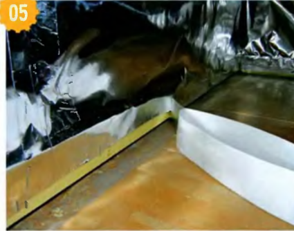
05 Края крафт-бумаги дополнительно крепили клейкой алюминиевой лентой.
