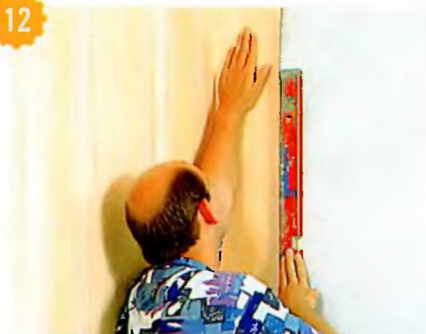
12 Приклеиваемое в углу полотнище загибают на 1–1,5 см за линию угла. С краем полотнища стыкуют только что отрезанную от него полосу, совмещая таким образом их рисунок. После этого на всякий случай проверяют край последней полосы на вертикальность.
