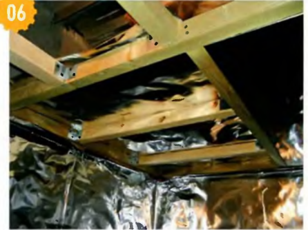
06 Пароизоляцию потолка укладывали сверху каркаса.
