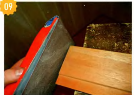
09 Торцы вагонки после распиливания шлифовали.
